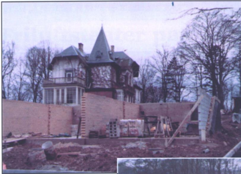
Underetagen af nr. 18 og 19 under opførel. Vejen er asfalteret og kantstenen ses forrest i billedet. Finn Johansen 1972/1973.
